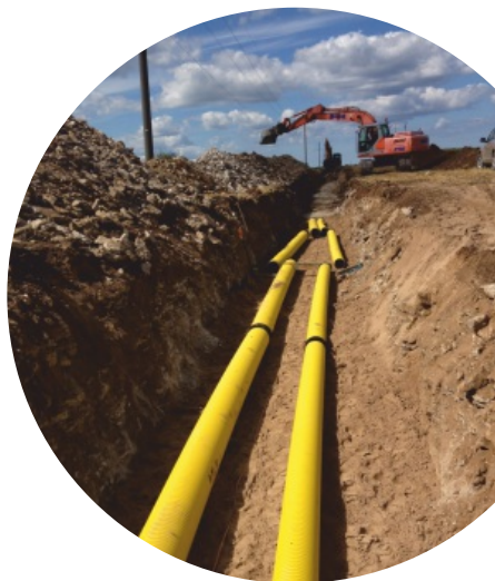
Estlink 2 Topeltseinaga kaablikaitsetoru paigaldus diameetriga 250 ja 315 mm
